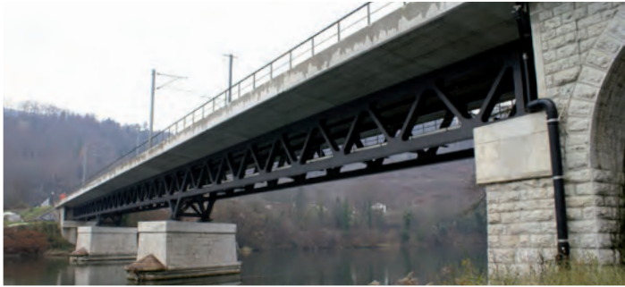
Vor dem Südportal des Hauenstein-Basistunnels quert die Hauensteinlinie die Aare auf einer modernen Verbundbrücke aus Betontrög und Stahlfachwerken.
