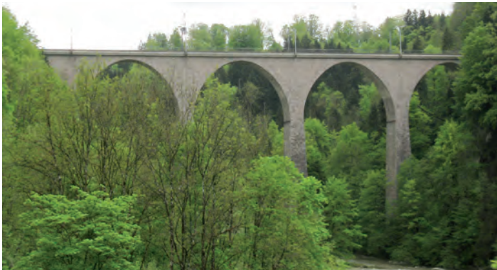
Die überhöhten Bogen des SBB-Viadukts über das Sittertobel bestehen aus Mauerwerk und Stampfbeton.
