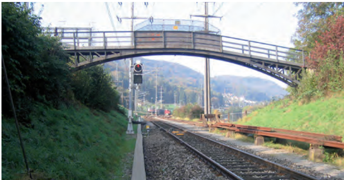
Die Passerelle führte Fussgänger von Stein nach Münchwilen über die Strecke Koblenz–Stein-Säckingen. Heute endet sie im Niemandsland zwischen Bahngleisen und ist gesperrt.
