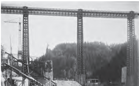
Die Vorgängerbrücke von 1856, ein vierfeldriger Durchlaufträger auf 47 m hohen Pfeilern – weltweit den ersten aus Eisen.
