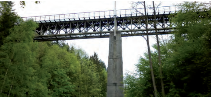
Zwischen Bischofszell und Hauptwil verläuft die Bahnstrecke um den Rässenberg herum und überquert auf der 20 m hohen Sorentalbrücke den Sornbach und die Strasse Hauptwil–Niederbüren.
