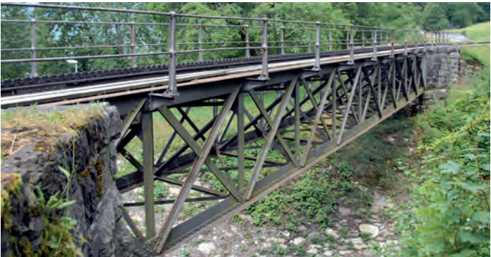
Etwa 600 m nach der Talstation überquert die Zahnradbahn auf das Brienzer Rothorn auf der Wellenbergbrücke den Trachtbach.
