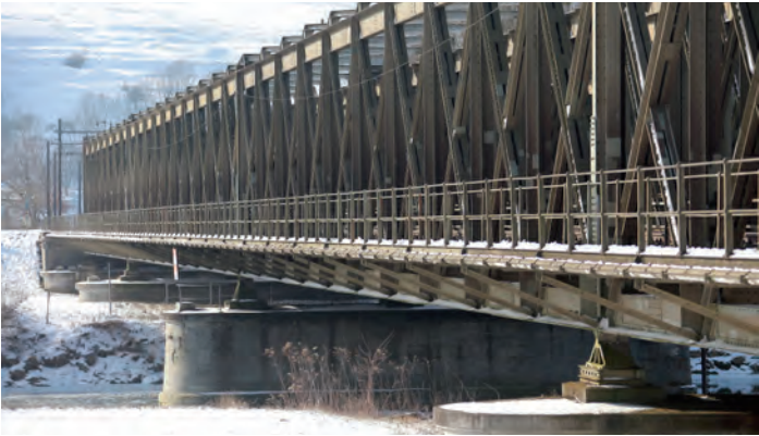
Zwischen Eschikofen und Müllheim führen zwei lange, baugleiche Fachwerkbrücken über die Thur und ihr Vorland.
