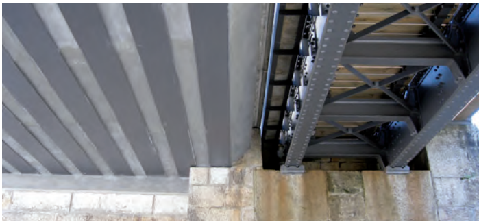
Über der Eptingerstrasse in Läufelfingen liegt der historische Vollwandträger (rechts) neben der noch genutzten Brücke aus Stahl und Beton.
