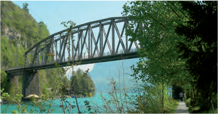
Zwischen Ringgenberg und Interlaken führt die Brünigbahn in 15 m Höhe über den Ausfluss der Aare aus dem Brienzersee und lässt Platz für die Kursschiffe.
