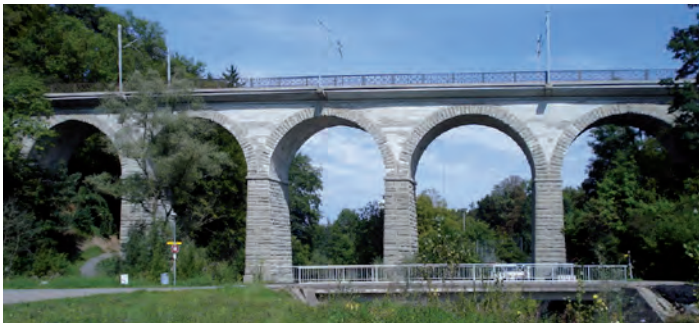
Der von Karl von Etzel entworfene Mauerwerkviadukt westlich des Bahnhof Goldach gehört zu den ältesten Schweizer Bahnbrücken.
