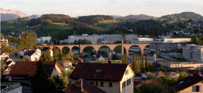
Der bis zu 32 m hohe Viadukt prägt das Ortsbild im Herisauer Glattal. Nicht weniger als sieben Strassen führen durch seine 14 Bogen.
