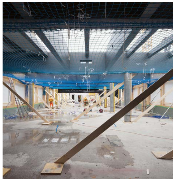
Komplexer Bauablauf und intensive Koordination zwischen Holzbau, Fassadenbau und Baumeisterarbeiten: Für das 4. OG wurden zuerst die Stützen und die Fassadenelemente gestellt , danach darauf mit kleinem Toleranzbereich die Träger montiert.
