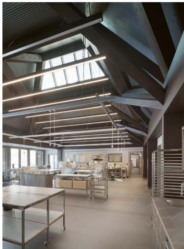
Ein Stabtragwerk für die grosse Spannweite von fast 20 m und Hauben für Schulungsräume (oben) und den Aufenthaltsraum (vgl. Abb. S. 31) – Tragwerk und Architektur verflechten sich.
