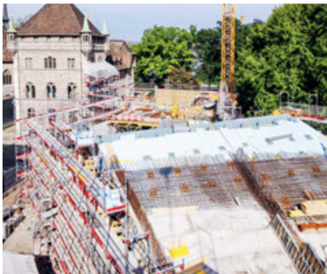
Baustellenfotos während den Ausführungsarbeiten an der Brücke. Die Neigungen der Brückenplatten betragen 45 und 27 Grad. Um sie betonieren zu können, sind Konterschaltungen erforderlich. Zuerst betonierte man die Untersicht der Brücke – die nichttragende Aussenhaut –, verlegte die Dämmung und die Bewehrung und betonierte anschliessend die tragende Platte.
