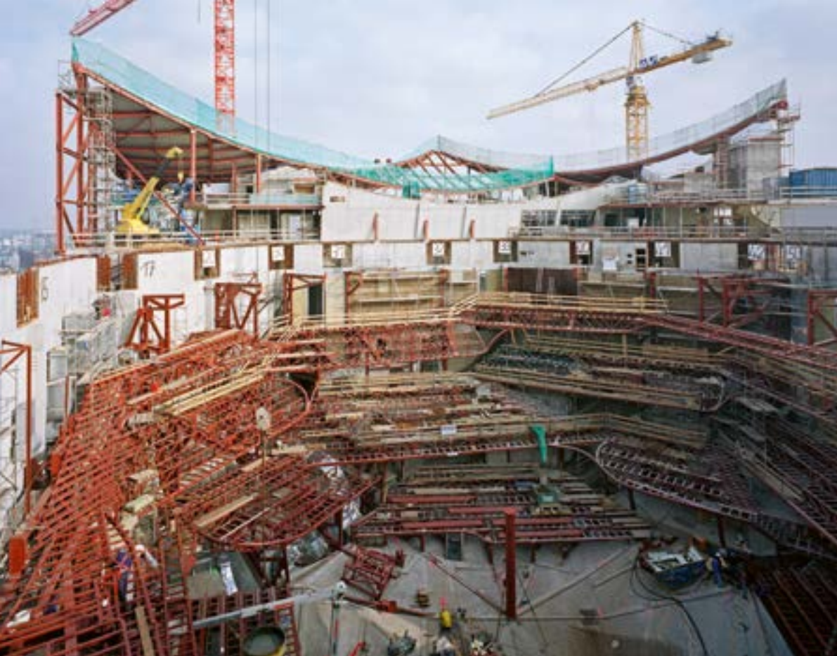
Baustellenbild der Aussenschale des grossen Saals als riesiger Betonkessel während des Baus 2009. Darin wird die Stahlkonstruktion der Innenschale aufgebaut – inklusive den weinbergartig abgestuften Tribünenpodesten.
