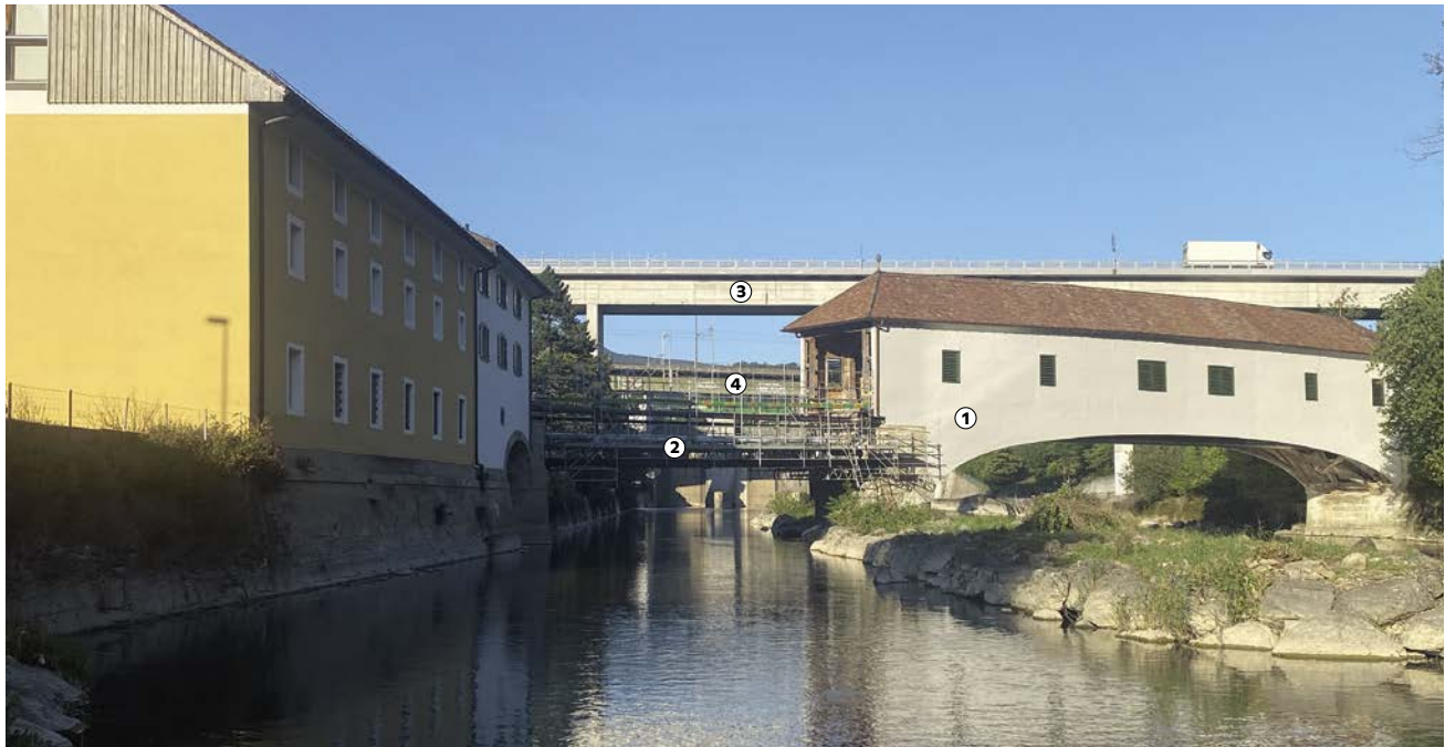
Die Holzbrücke ① mit ihrer Vorbrücke aus Eisen ② zwischen Neuenhof und Wettingen diente noch bis zum Bau einer neuen Stahlbetonbrücke ③ als Kantonsstrasse. Im Hintergrund ist die SBB-Brücke ④ auf der Strecke Baden–Zürich erkennbar.
